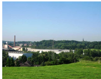
Glaswerke / Glasfabrieken St. Gobain (Herzogenrath)
