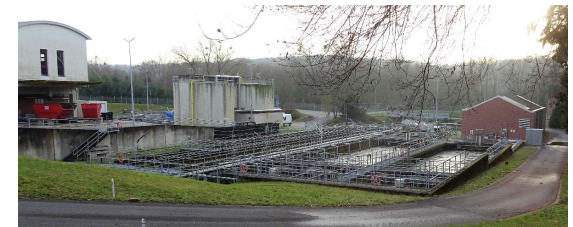
Zuiveringsinstallatie Worm / Kläranlage Worm (Peter Kuhn)
