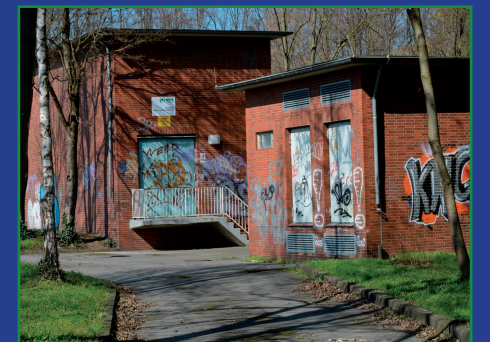
Pumpwerk Lippeverband Geitheschöpfwerk
