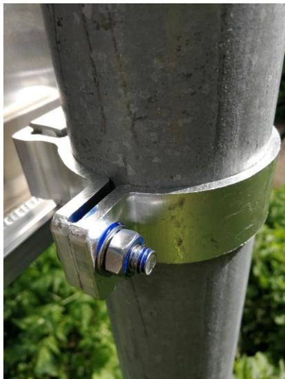
Beispiel: Befestigungsschelle für eine Informationstafel. Hier: Schellen mit Schrauben/Gewinde-Fix (blau), so dass Tafel schwer demontierbar ist (WasserWeg Omerbach/Inde).
