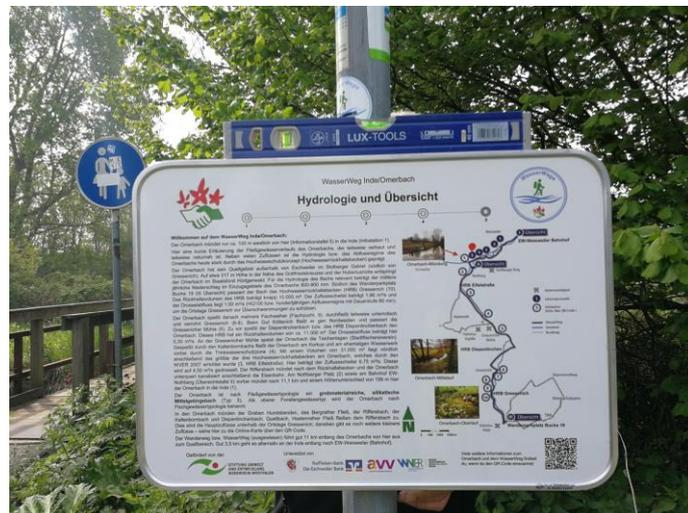
Beispiel: Montage einer DIN A2-Tafel an einem vorhandenen Pfosten (mit Quick-Fix gegen Demontage) und Wasserwaage für die Ausrichtung (WasserWeg Omerbach/Inde, Eschweiler)
