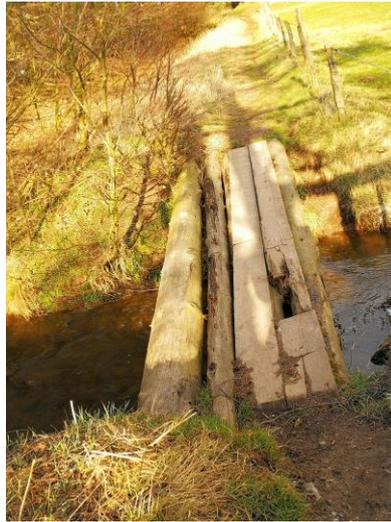
*Beispiel: Vorhandene nicht gesicherte Infrastruktur/Wege. Hier: ungesicherte und offiziell gesperrte Brücke über den Omerbach (WasserWeg Omerbach/Inde).*
